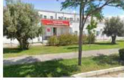
Cengizhan Mahallesi, 37908 ada 1 parşel üzerinde bulunan Spor Salonu
